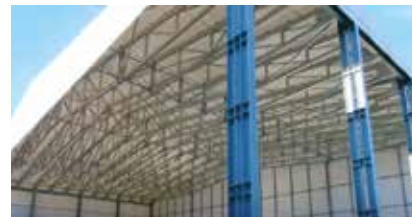
INSTALLARE SISTEMI DI DETERRENZA OLFATTIVO/VISIVA PER DISINCENTIVARE IL RITORNO DEI VOLATILI (ES. GEL REPELLENTE)
